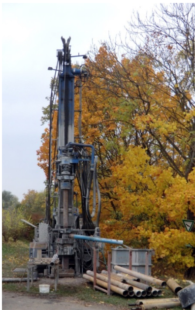
Bohrer für Bodenuntersuchungen, © wsv.de
