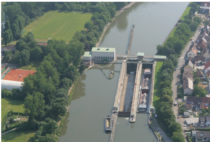
Die Staustufe Horkheim aus der Luft, © wsv.de
