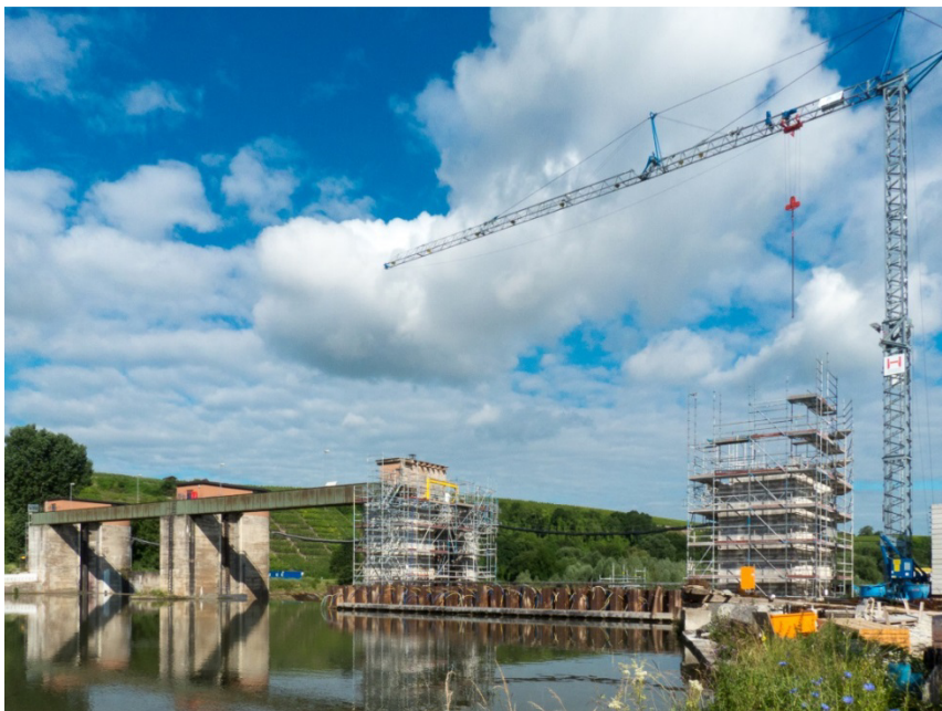
Grundinstandsetzung des Wehrs Horkheim © wsv.de
