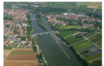
Luftbild der Schleuse Lauffen
