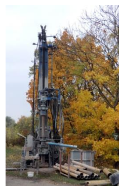
Bohrer für Bodenuntersuchungen
