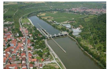
Luftbild der Schleuse Hessigheim mit dem Wehr und Kraftwerk
