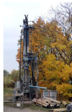
Bohrer für Bodenuntersuchungen
