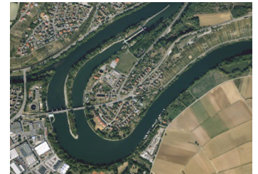
Luftbild der Schleuse Besigheim und der Stadt Besigheim mit Neckarschleife
