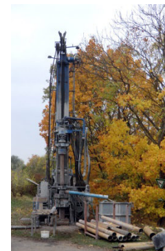
Bohrer für Bodenuntersuchungen
