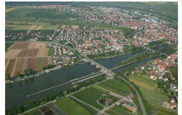
Staufstufe Lauffen aus der Luft
