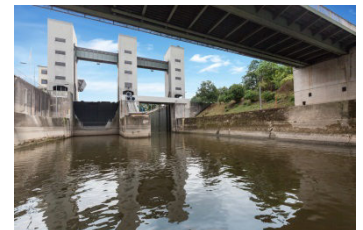
Schleuse Feudenheim im Unterwasser, derzeitiger Zustand © neomind.
