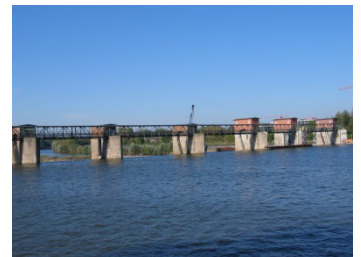
Wehr Wieblingen, Blick vom Oberwasser
