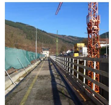
Gesicherte Mittelmole der Schleuse Hirschhorn (Blick flussaufwärts, linke Schleusenammer zur Rechten)
