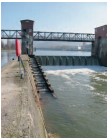
Bild 3: Fischwanderhilfe am Wehr Heidelberg-Wieblingen
