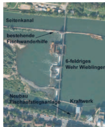
Bild 2: Wehr Heidelberg-Wieblingen mit Kraftwerk und Seitenkanal, bestehender Fischwanderhilfe sowie potenzieller Lage der geplanten Fischaufstiegsanlage
