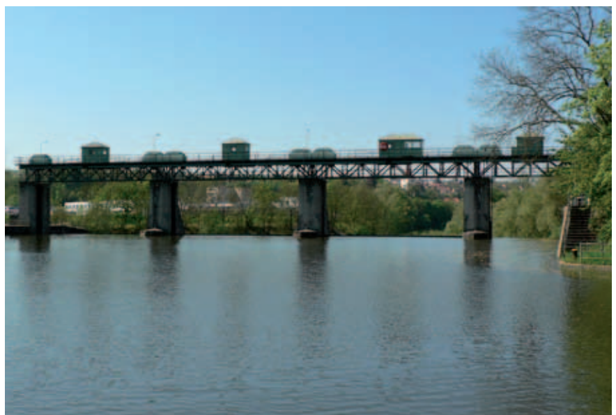
Bild 2: Das seit 1915 betriebene Wehr Beihingen
