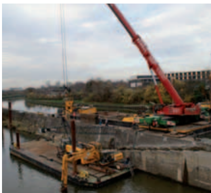
Bild 6: Ausheben eines Stelzenpontons mit Baugeräten aus dem Unterwasser des Wehres Wieblingen
