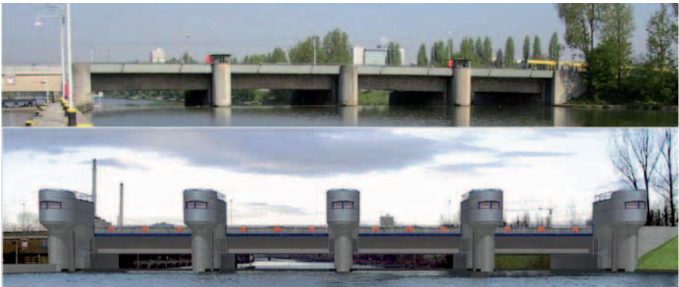
Bild 8: Wehr Untertürkheim in der Ansicht von Oberwasser vor (oben) und nach (unten, Fotomontage) der Grundinstandsetzung
